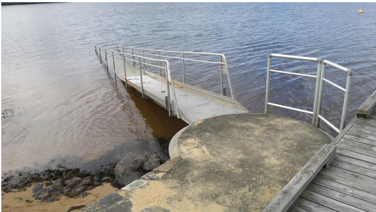
Baderampe på Storebanken
