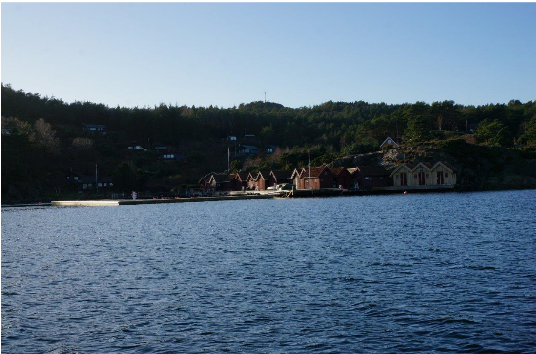
Del av eksisterende bebyggelse. Havneområde BSB9/BBS9, med ny flytebrygge og brygger, sjøboder og hytter i bakgrunnen. Garpeheia i midten bak.
